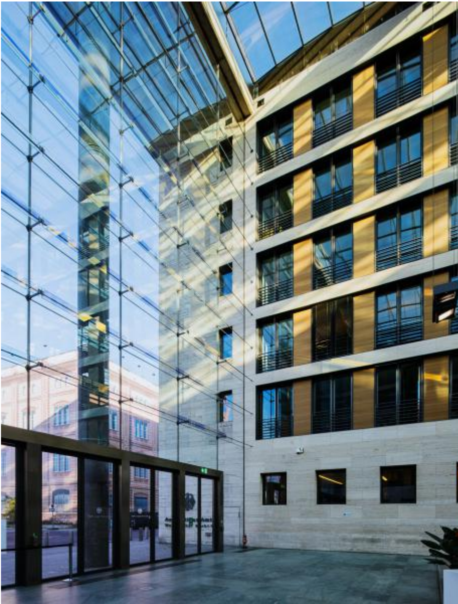
James Fraser Carpenter: o. T. (Glasfassade), 1999 / © James Fraser Carpenter; Fotonachweis: BBR / Cordia Schlegelmilch (2016)
