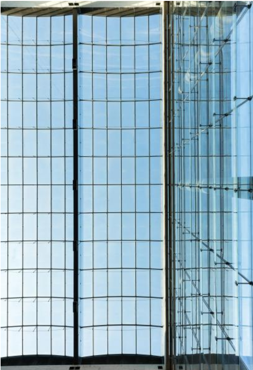
James Fraser Carpenter: o. T. (Glasfassade), 1999 / © James Fraser Carpenter; Fotonachweis: BBR / Cordia Schlegelmilch (2016)
